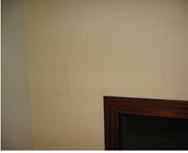
FOTO 7: HABITACIÓ H1 EXTERIOR
