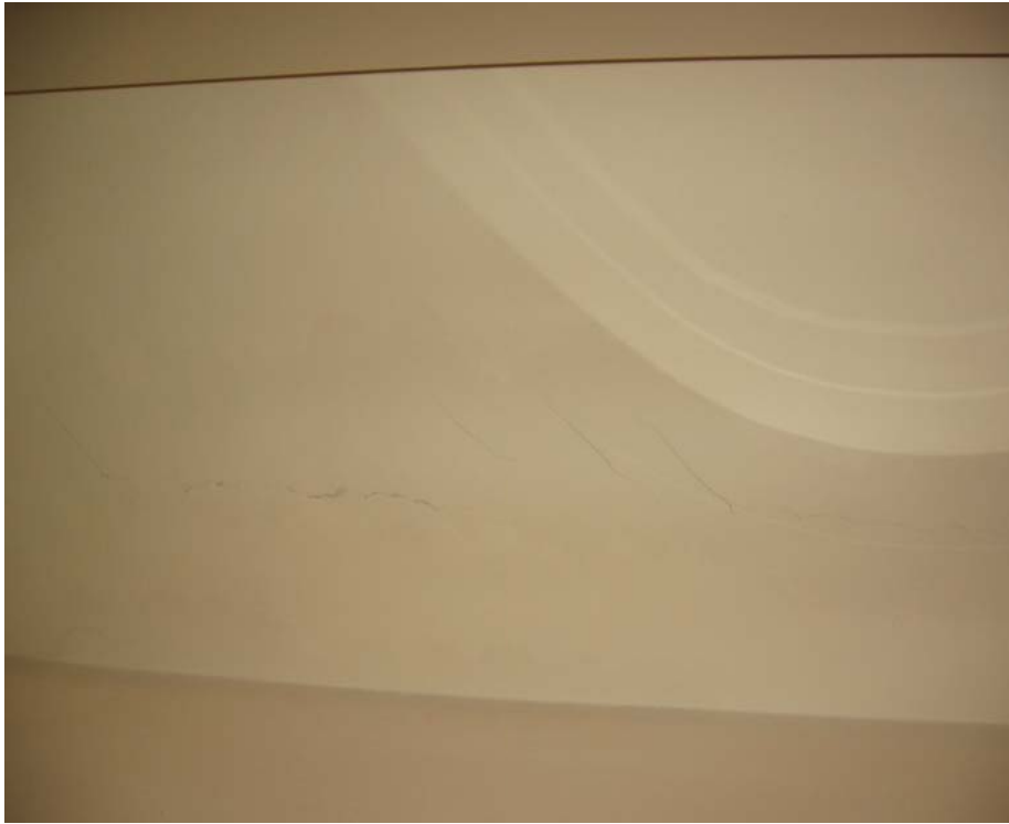
FOTO 30: HABITACIÓ H1 INTERIOR
