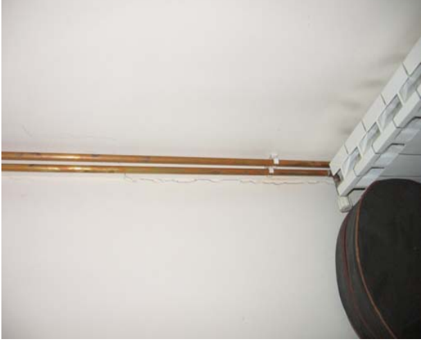
FOTO 8: HABITACIÓ H1 INTERIOR
