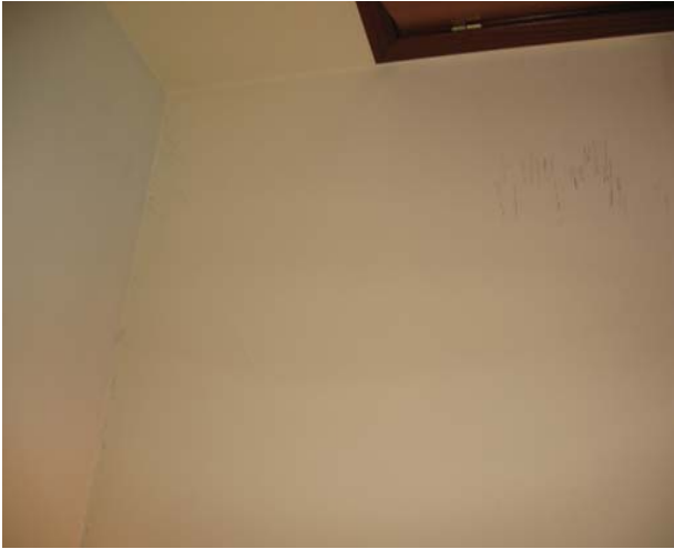
FOTO 1: HABITACIÓ H3 INTERIOR
