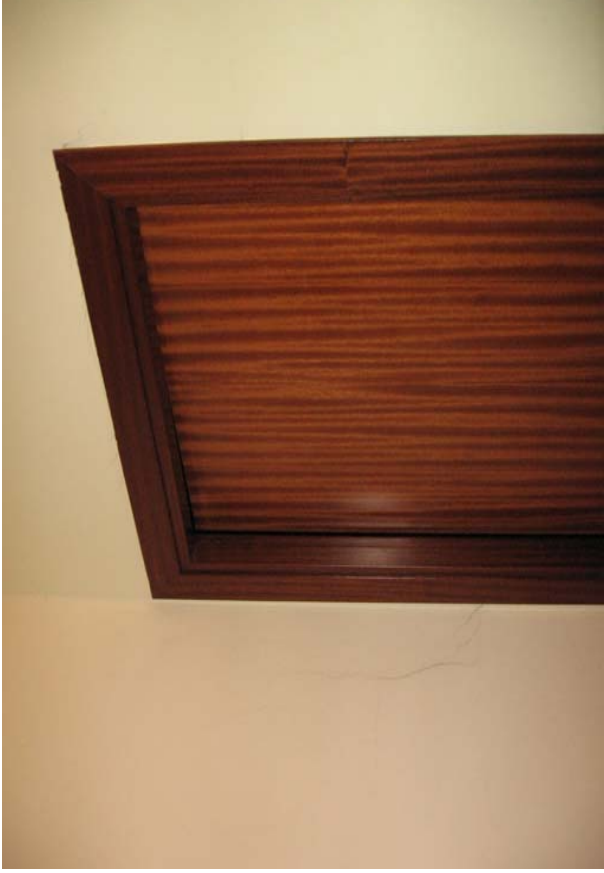
FOTO 6: BANY C1 EXTERIOR
